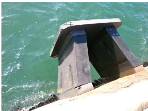
Εικόνες 12-13: Τυπικές εικόνες προσκρουστήρων προβλήτα ΣΕΜΠΟ χωρίς φθορές υλικού (προς συντήρηση)
