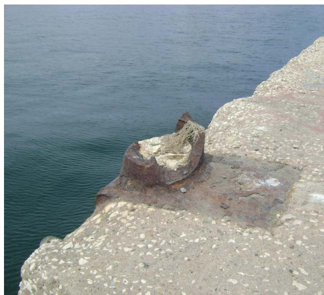
Εικόνα 14: Δυτικό κρηπίδωμα κεντρικού εμπορικού προβλήτα δυτικού τομέα λιμένα. Επισημαίνεται η θέση της προς αντικατάσταση σπασμένης δέστρας
