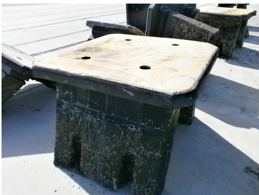
Εικόνες 10-11: Τυπικές εικόνες καθαιρεθέντων προσκρουστήρων που ανελκύστηκαν (δυνατότητα επαναχρησιμοποίησης ελαστικών αποστατών και αντιτριβικών πλακών που έχουν διατηρηθεί σε καλή κατάσταση)
