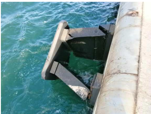
Εικόνες 6-9: Τυπικές εικόνες φθορών προσκρουστήρων προβλήτα ΣΕΜΠΟ (προς αντικατάσταση – επισκευή)
